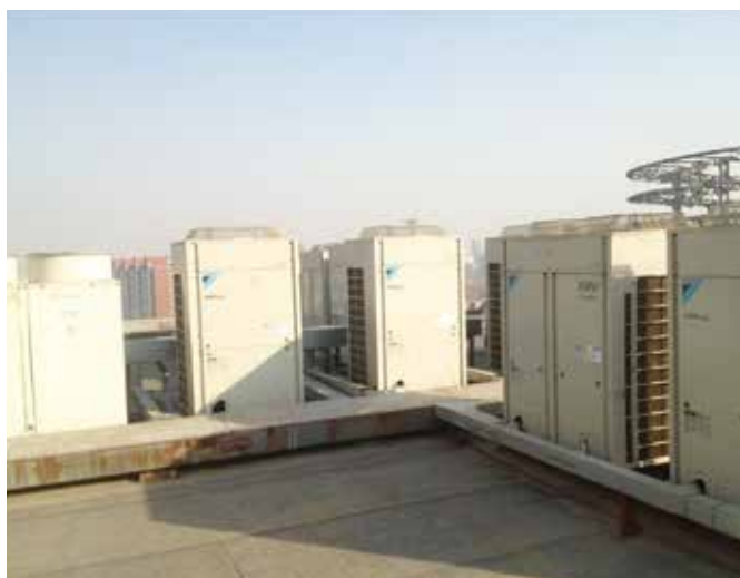
施工後 安裝 VRV Q
