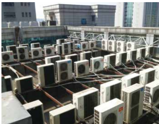
施工前 安裝多種品牌
