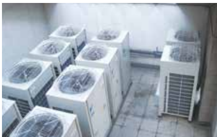
原使用 R22 的 VRV 設備由 R410A 的 VRV III-Q 取代。
