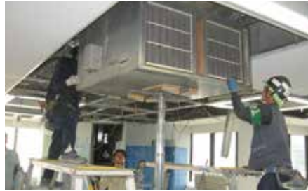
2 拆除現有的室內機
