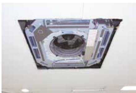
安裝新室內機
