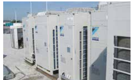
VRV III-Q 使用 R410A，確保符合最新的標準。
