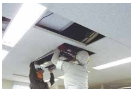
移除舊室內機
